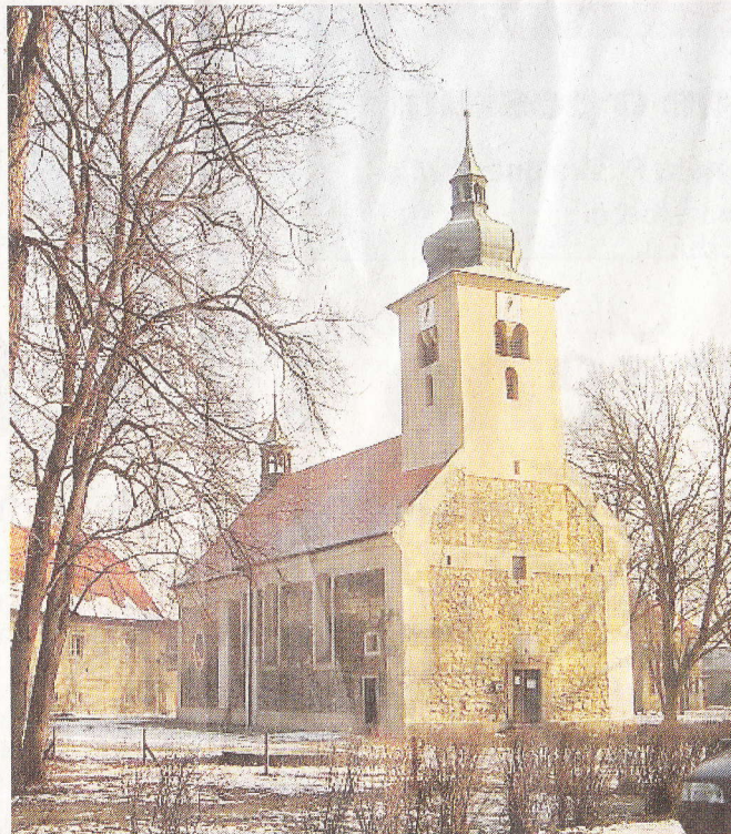
DŘÍVE A NYNÍ. Takhle vypadal lenešický kostel sv. Šimona a Judy ještě před zřícením (vlevo), dnes na místě věže zeje díra. Průzkum odhalil, že věž se zřítla kvůli přestavbě na začátku 19. století, kdy byly postaveny dvojce dveře a užit nekvalitní materiál. FOTA: MARTIN SOUKUP A MAFA
