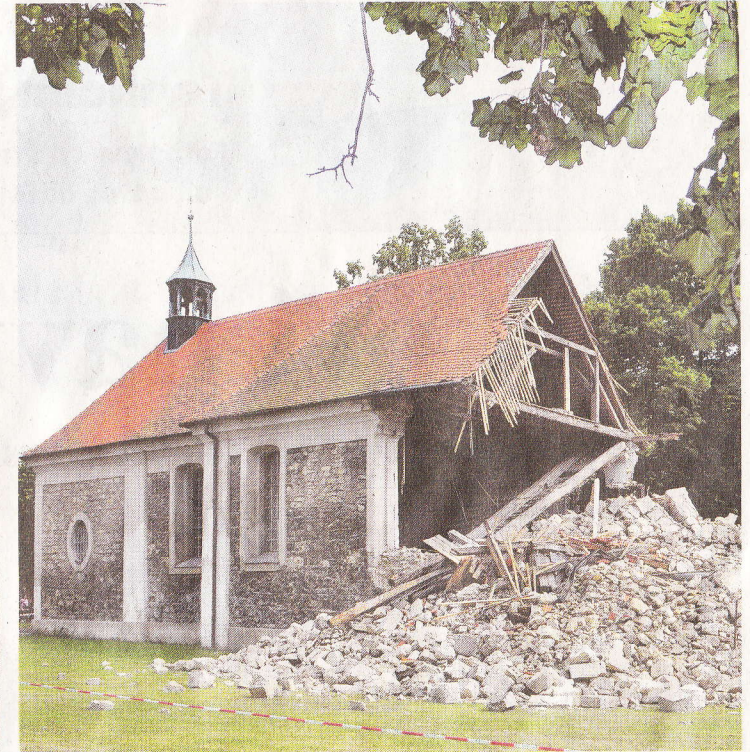
DŘÍVE A NYNÍ. Takhle vypadal lenešický kostel sv. Šimona a Judy ještě před zřícením (vlevo), dnes na místě věže zeje díra. Průzkum odhalil, že věž se zřítla kvůli přestavbě na začátku 19. století, kdy byly postaveny dvojce dveře a užit nekvalitní materiál. FOTA: MARTIN SOUKUP A MAFA
